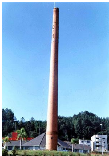
Fig. 36 – Chaminé da antiga sede da Cimo, em Rio Negrinho
