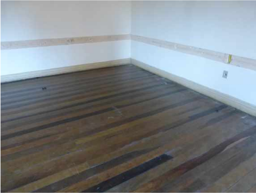
Foto 31: Sala 13 – Piso em boas condições.
