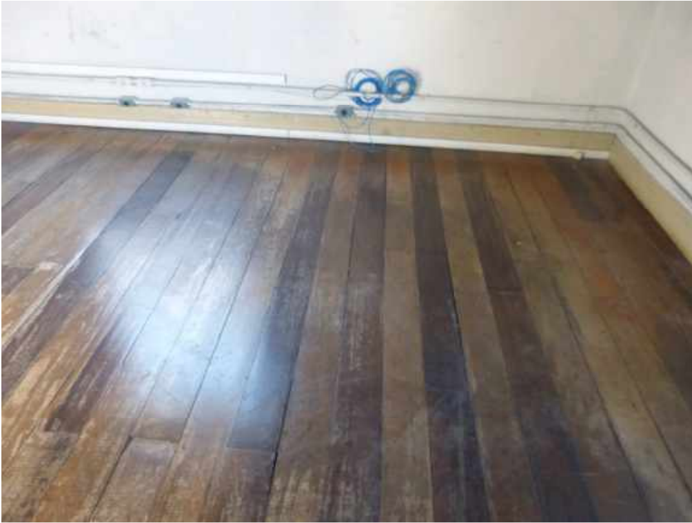
Foto 13: Sala 25 – Piso em bom estado.
