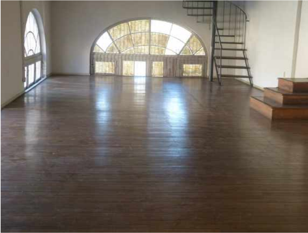
Foto 21: Sala 15 – Piso em bom estado.
