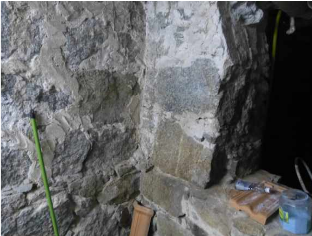
Foto 38: Paredes de pedra argamassada.
