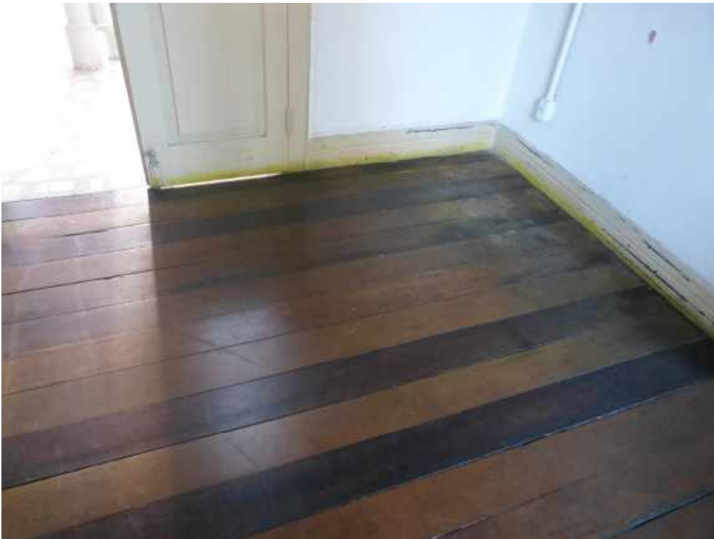
Foto 14: Sala 26 – Piso em bom estado.
