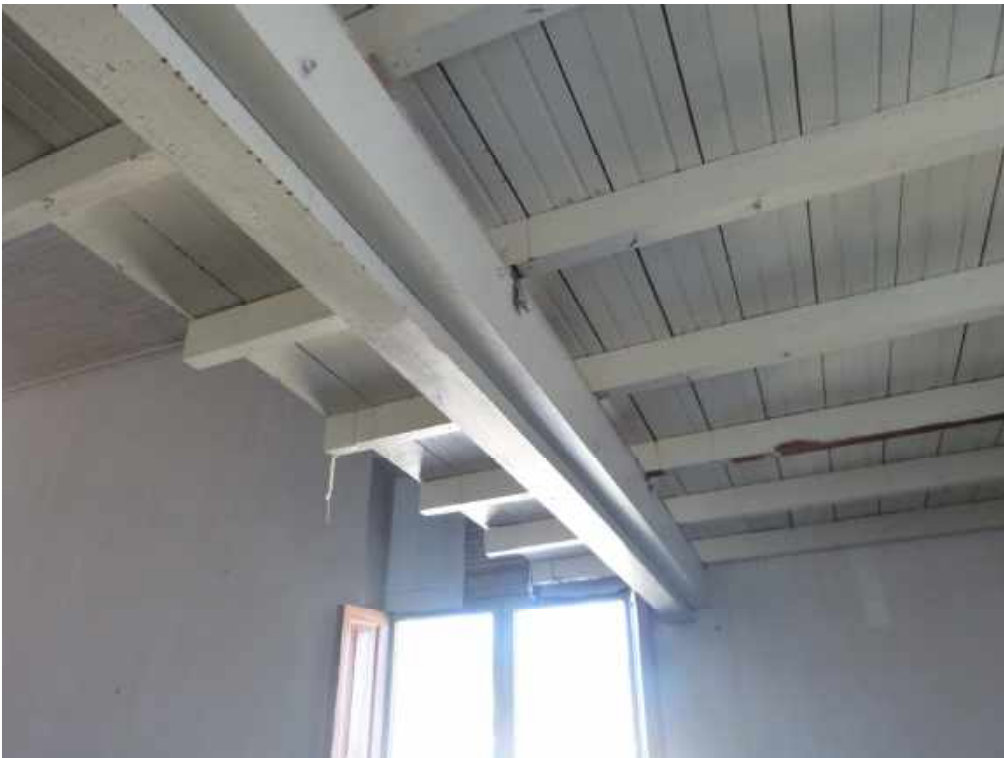
Foto 4: Mezanino – Estrutura e piso em bom estado.
