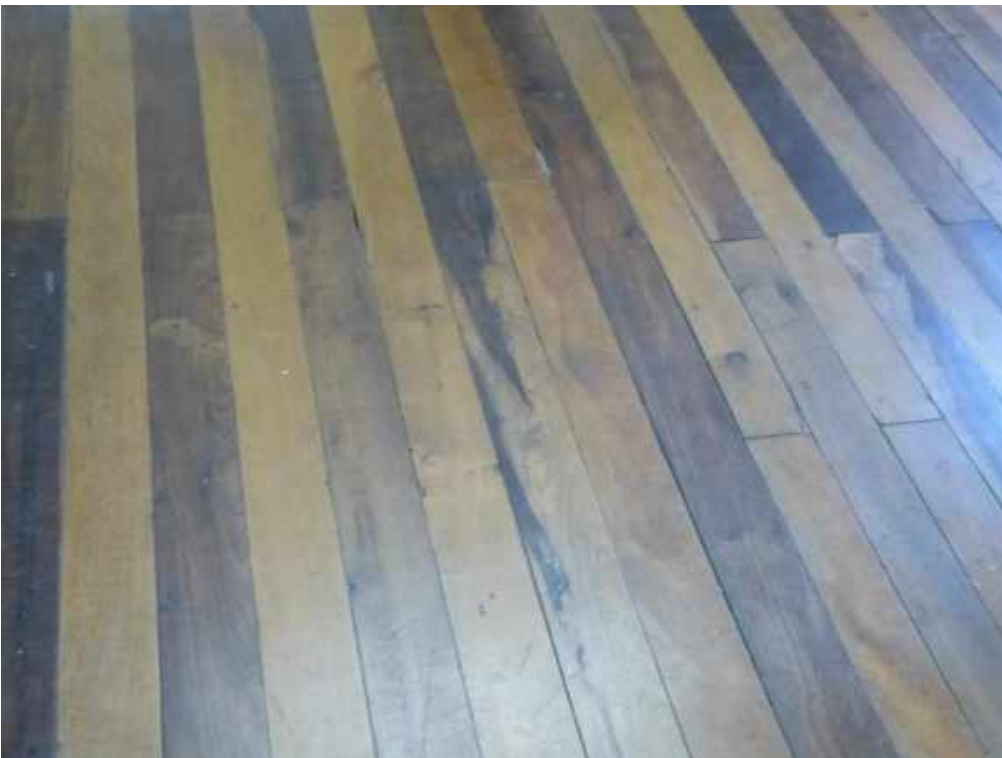
Foto 26: Sala 04 –Piso em boas condições.
