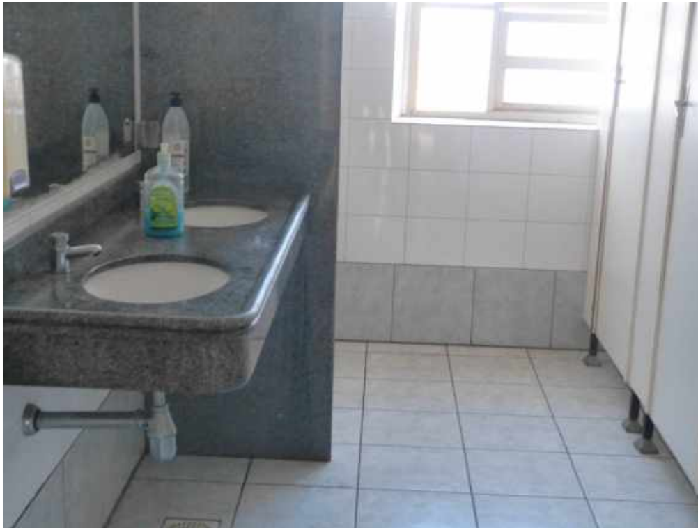
Foto 23: Sala 07 – Banheiro masculino – OK.
