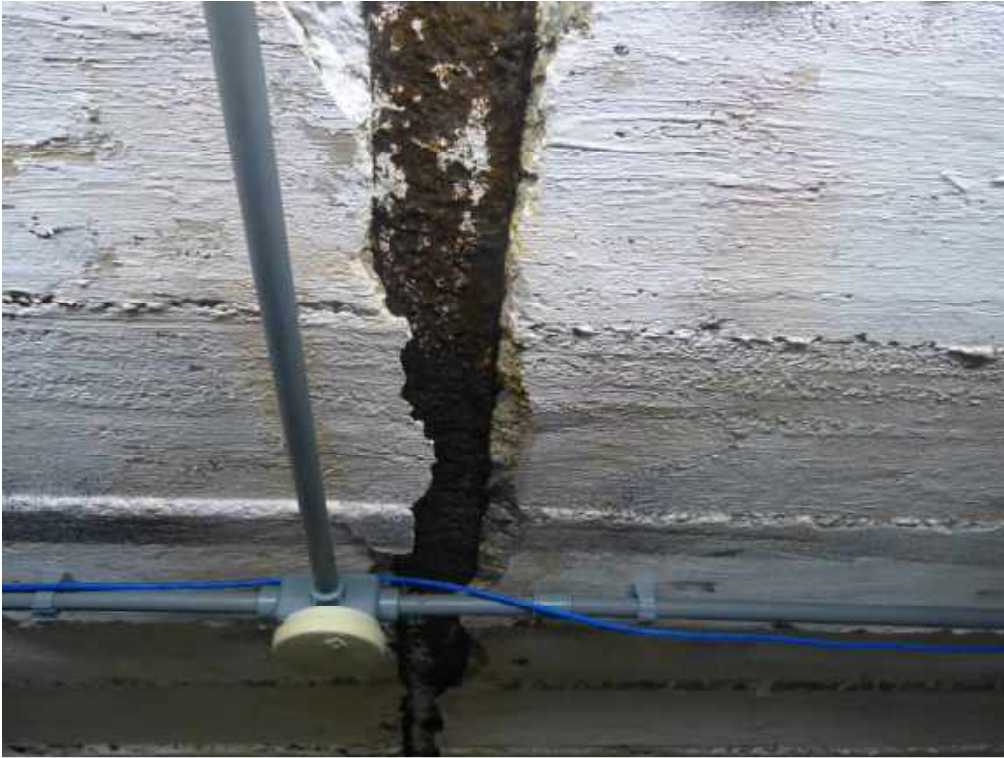
Foto 39: Vigamento de aço, corroída.
