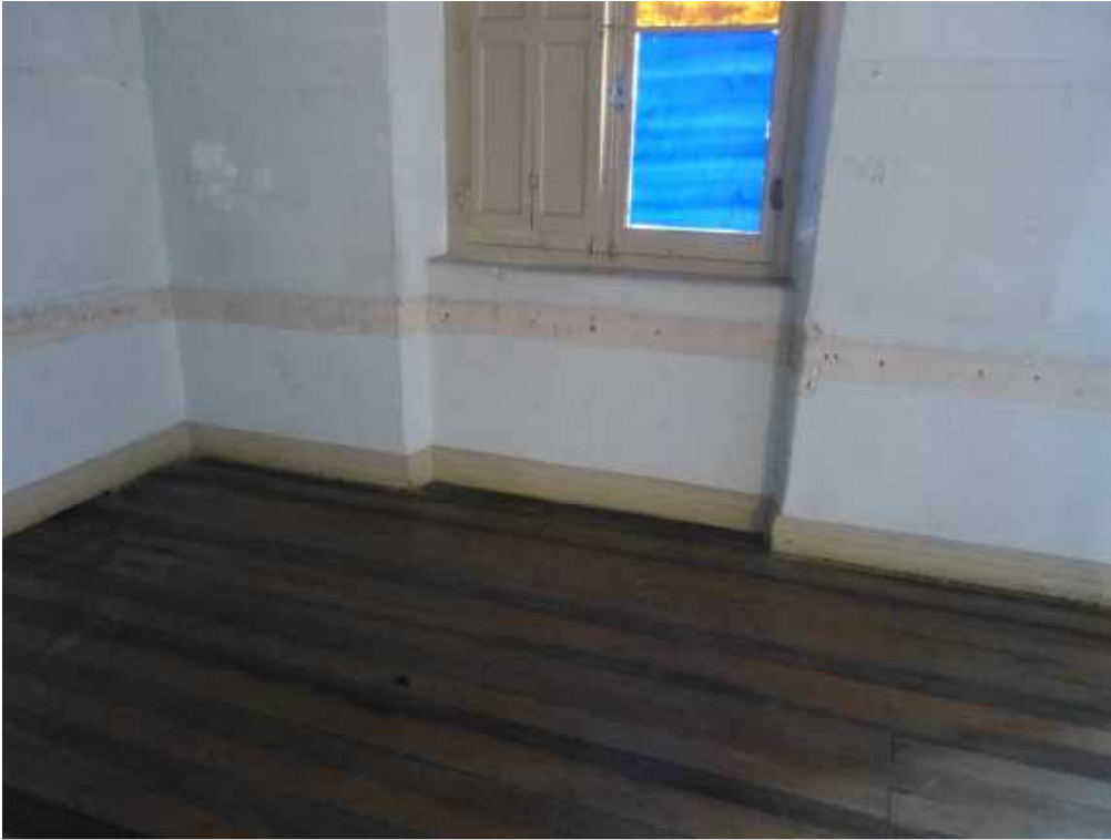
Foto 29: Sala 14 - Piso em bom estado.
