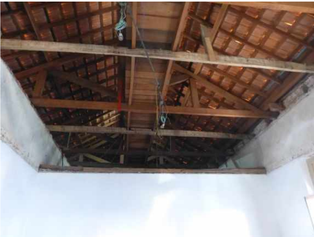
Foto 8: Sala 22 – Sem forro.
