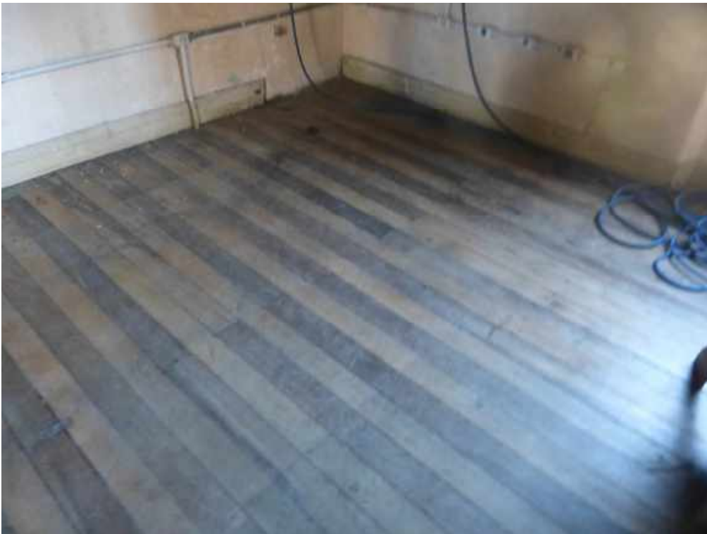
Foto 28: Sala 29 – Piso em bom estado.
