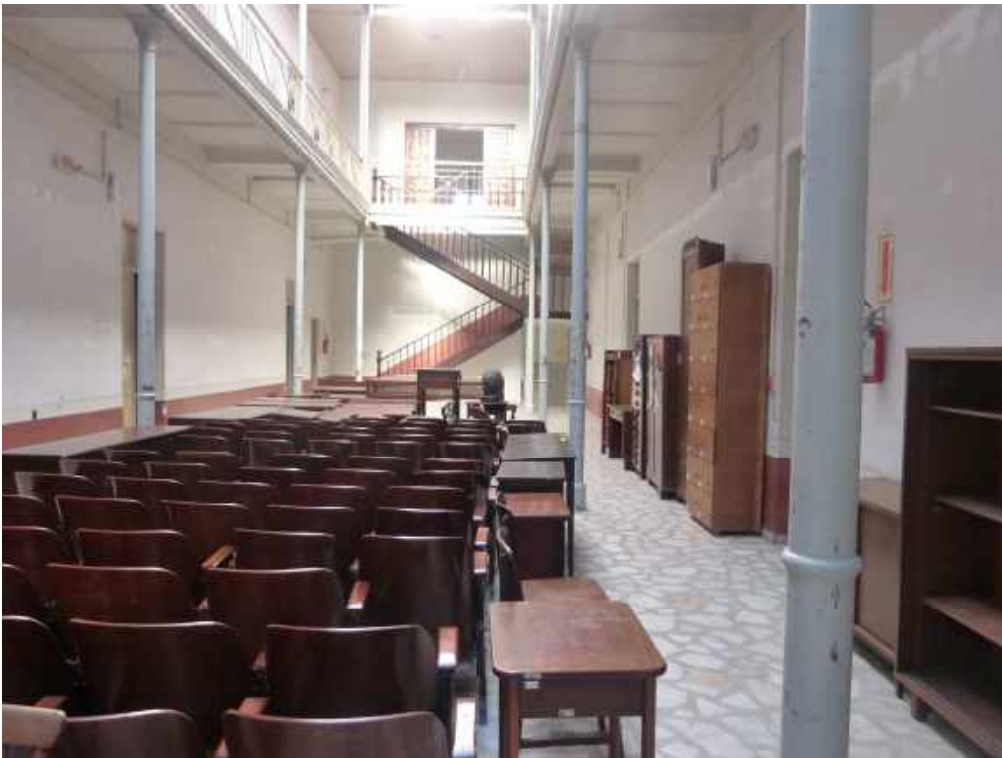
Foto 30: Sala 03 – Visão geral desde a entrada. Notar pilares em ferro.
