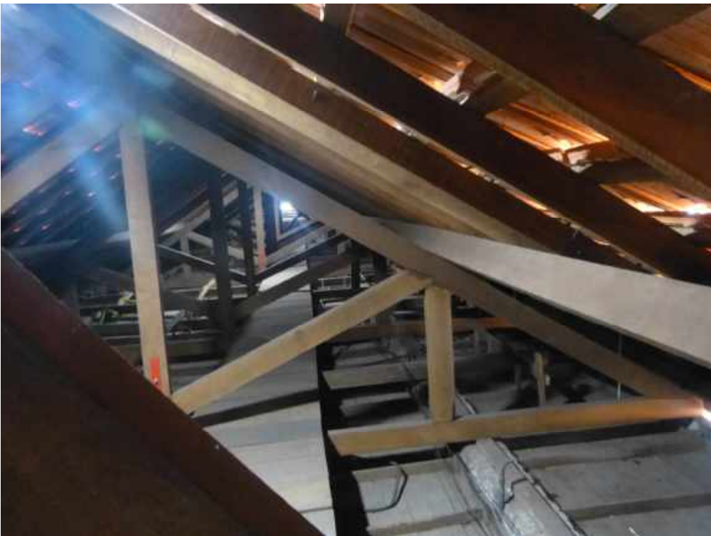
Foto 2: Estrutura do telhado no sótão.
