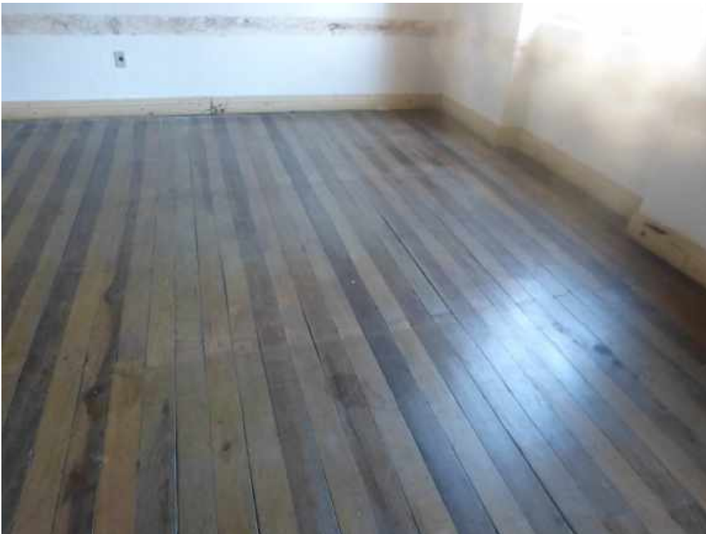
Foto 32: Sala 12 – Piso em boas condições.
