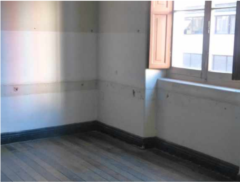
Foto 25: Sala 05 – Piso em boas condições.
