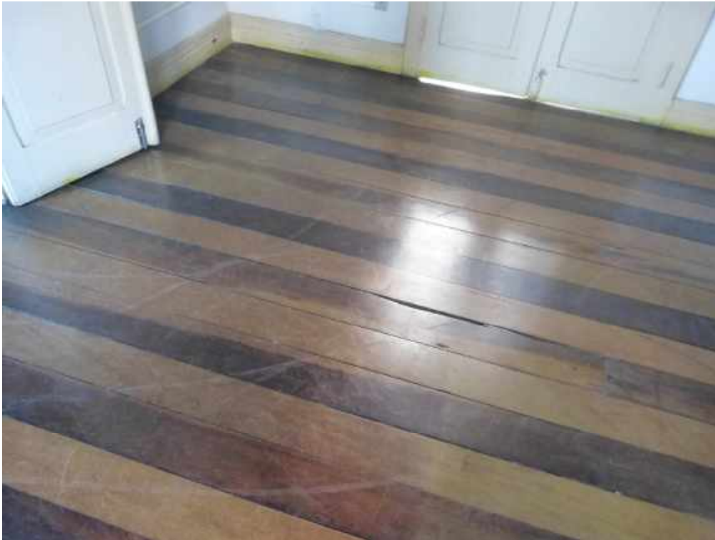
Foto 15: Sala 27 – Piso em bom estado.
