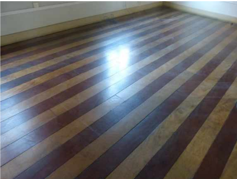
Foto12: Sala 24 – Piso em bom estado.
