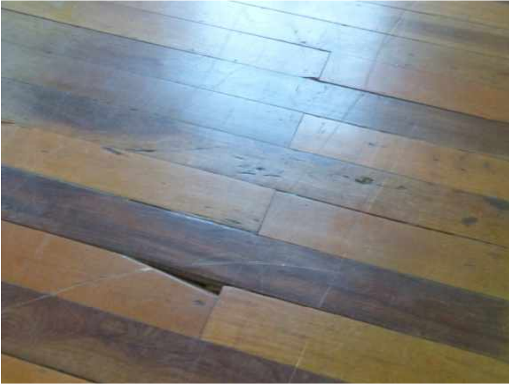
Foto 19: salas 19e 20 – Piso em bom estado.
