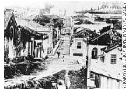
Rua Saldanha Marinho antes da construção do casarão histórico
